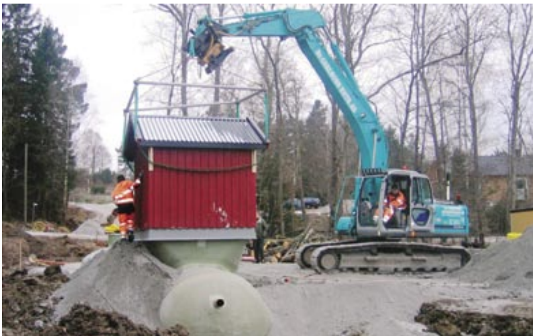
Bilden visar installation av ett BAGA reningsverk i Skåpesund, Tjörns kommun, för 22 hushåll. Servicehuset lyfts på plats. Installationen utförd av Bröderna Carlson Entreprenad AB i Kungälv.
