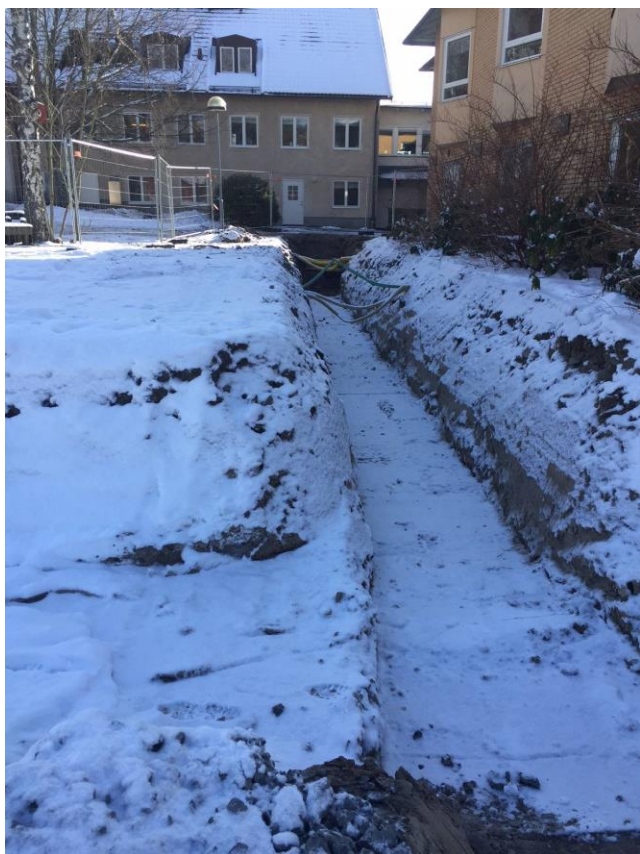
Rörgrav för vatten och avlopp.
