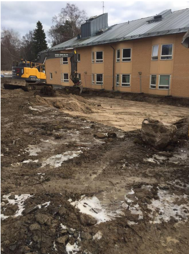
Markarbeten precis utanför Djuröhemmet.
