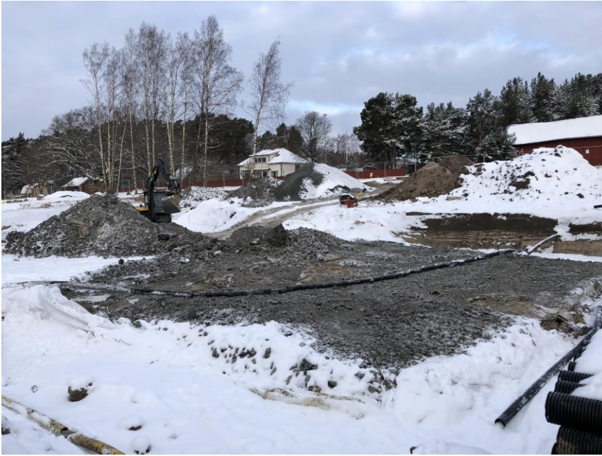
Jordmassor som ska köras bort och grus som ska fördelas och jämnas till för Djuröhemmets betongplatta.
